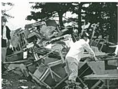
津浪で被災した病院がれき撤去作業
