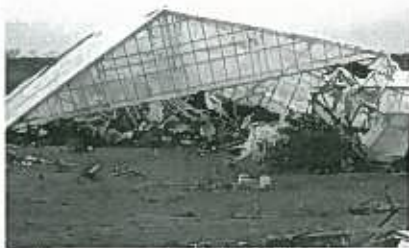
津浪で破壊されたトマトハウス
